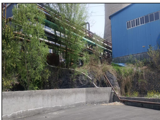
项目锅炉房南侧现状
