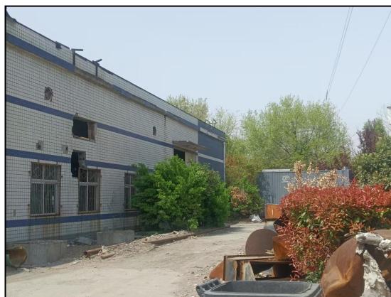
项目锅炉房北侧现状
