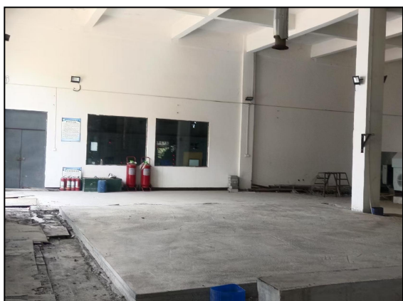
项目车间内部现状
