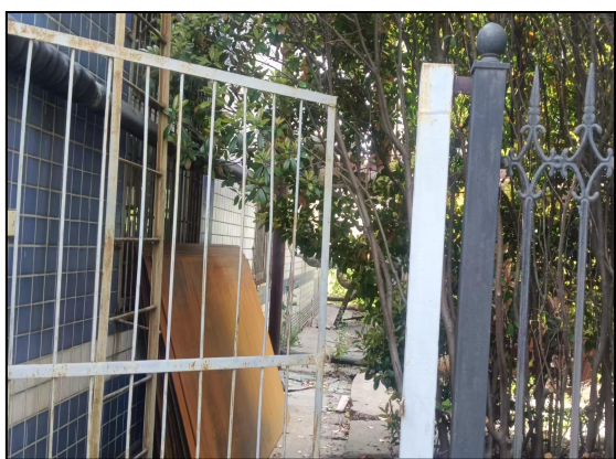
项目锅炉房西侧现状
